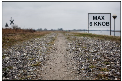
Skarpe skærver ødelægger dækkene
