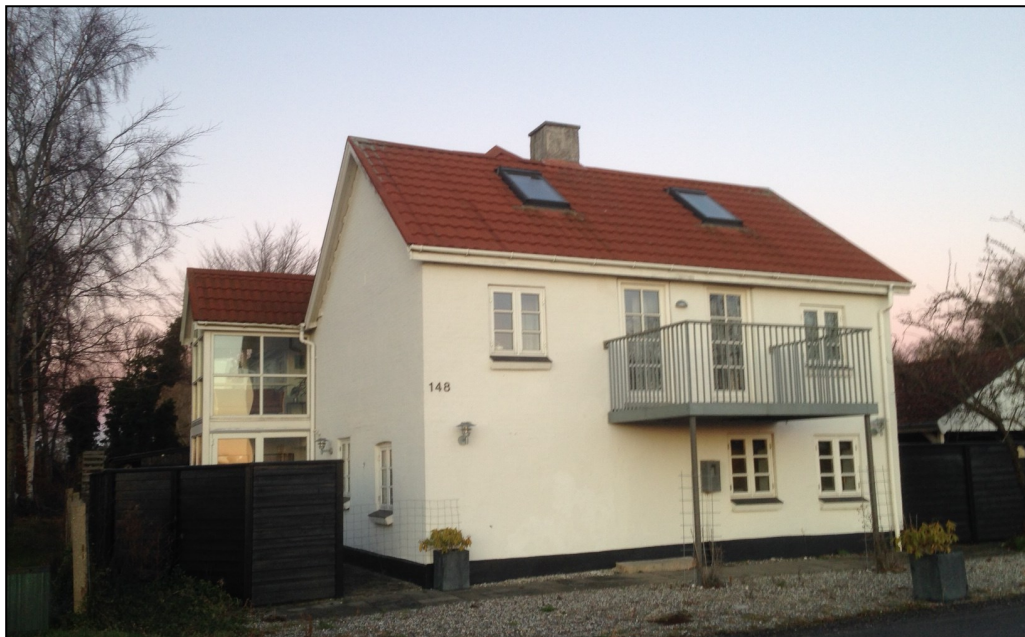
Maise Rasmussens hus i Klintebjerg - huset kaldes også for "Højhuset"
