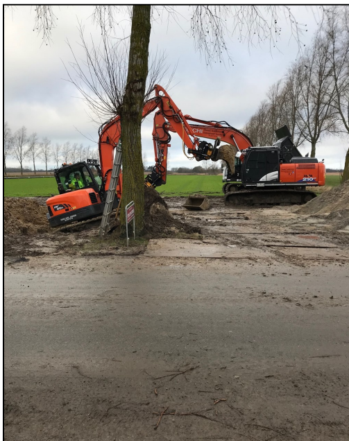
Der arbejdes med at grave fjernvarmerør ned ved gartneriet Timmermann
