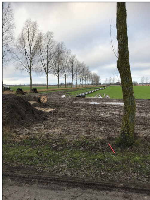
Fjernvarmerør klar til at blive lagt i jorden - over for gartneriet Timmermann
